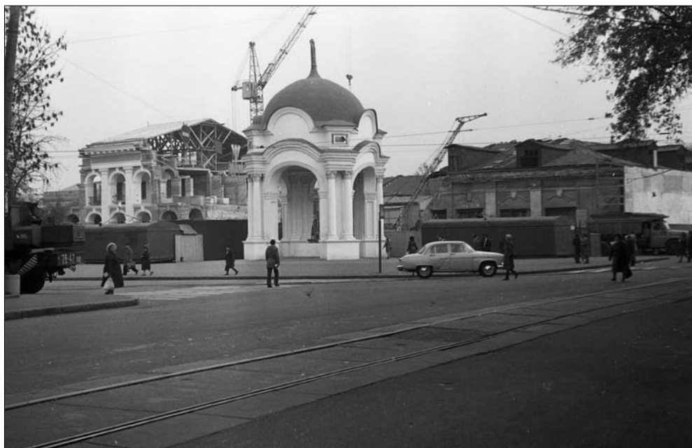
▲ Фасад Гостиного двора до реконструкции. 1970-е гг.
